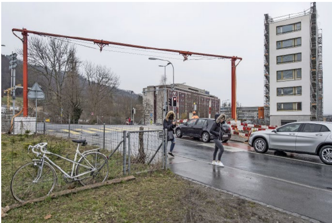
Auf dem Avaloq-Grundstück wird bereits gebaut; ein Campus und Wohnhäuser entstehen. Foto: Doris Fanconi
